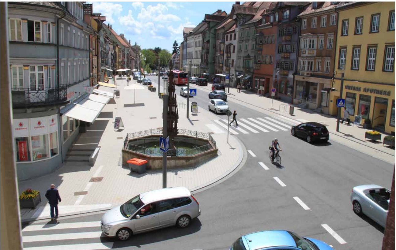
Abbildung 4: Neue Straßengestaltung in Rottweil, Foto: Stadtverwaltung Rottweil
